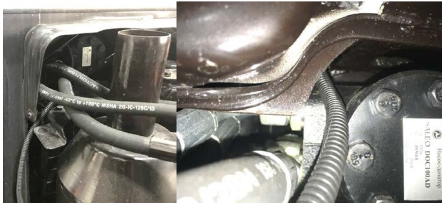
Рис. 4.3.23 – Протяжка жгута кабины в моторном щитке кабины
